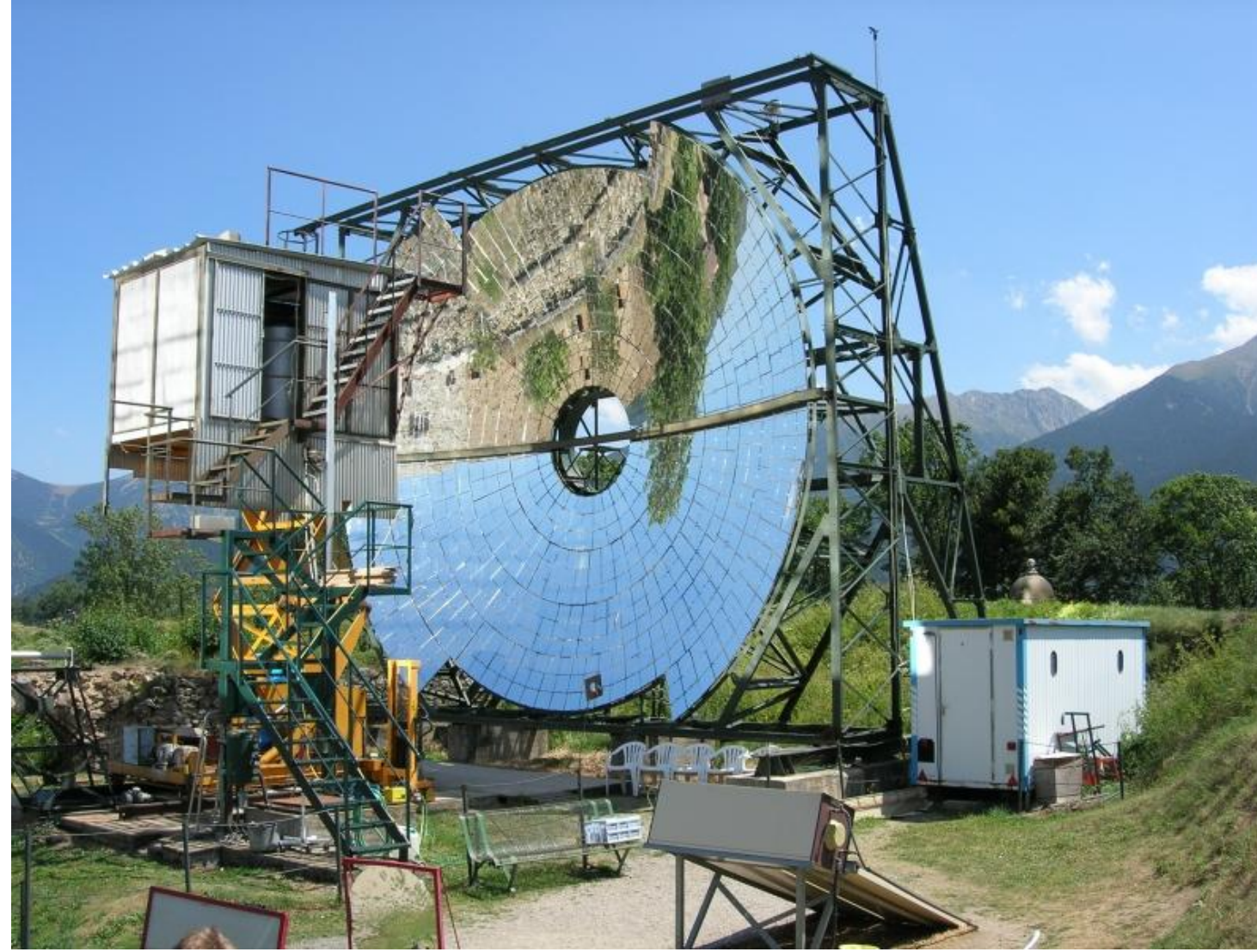
Miroir parabolique du four solaire de Mont-Louis
